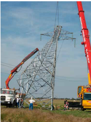
Levage de pylône
