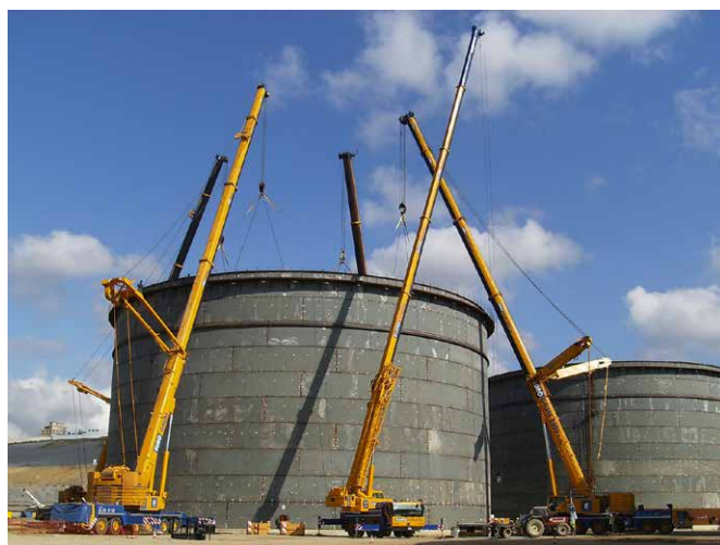
Montage des réservoirs de combustibles
