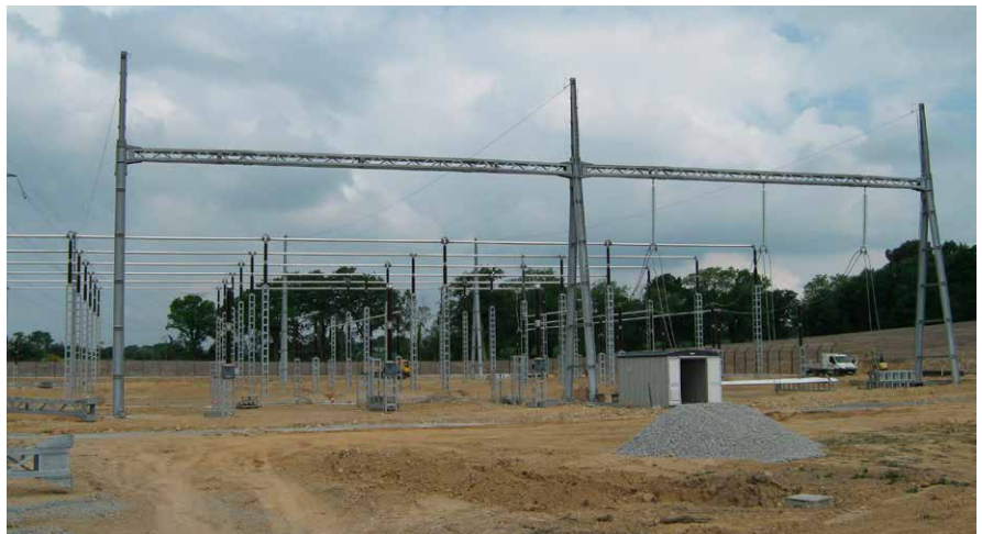
Construction d'un poste électrique (érection des charpentes)
