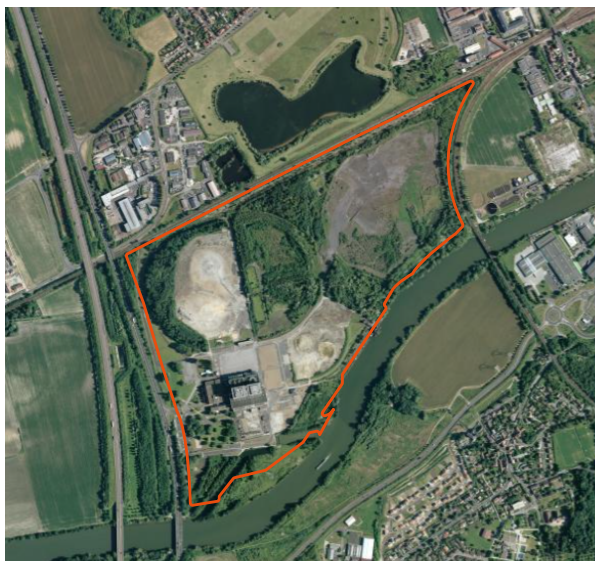
2015 Après l'arrêt de production de la centrale à charbon
